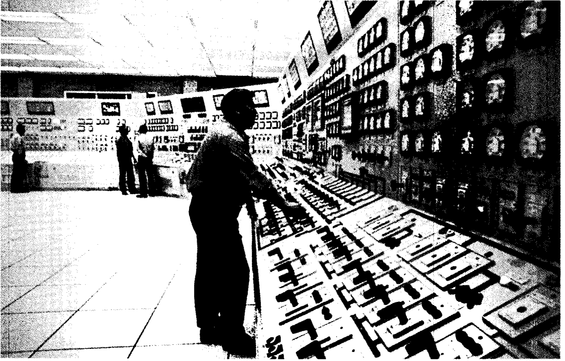
غرفة التحكم المركزية في محطة قدرة نووية كبيرة. تشتمل على مئات الأجهزة الإلكترونية، بعضها يساعد على تنظيم عمليات الإنتاج وبعضها الآخر يراقب كثيراً من أنظمة الأمان في المحطات.
